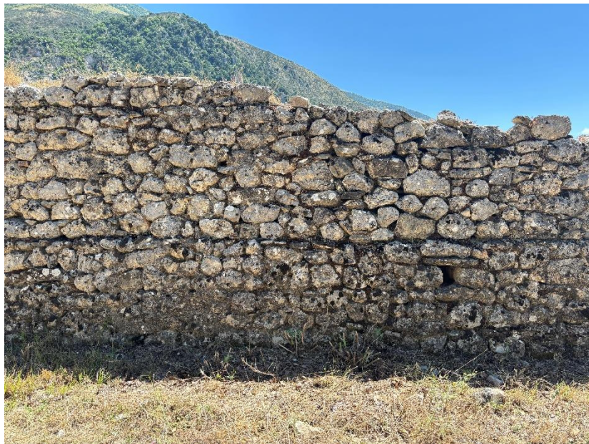
Fig. 5 Degradimi i materialit lidhës
