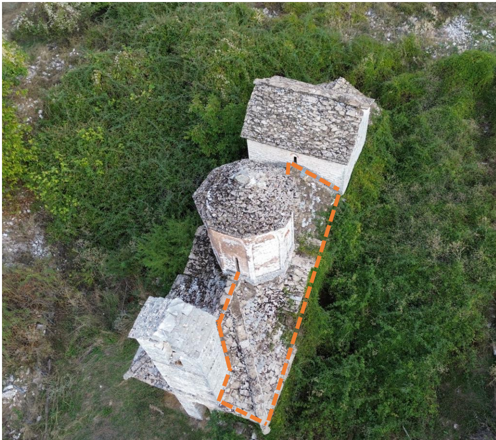
Figure 13 Pastrim i çatisë ku do të nderhyet pasi paraqet shkitje të rasave të gurit dhe mbulim nga bimesia kacavjerrse
