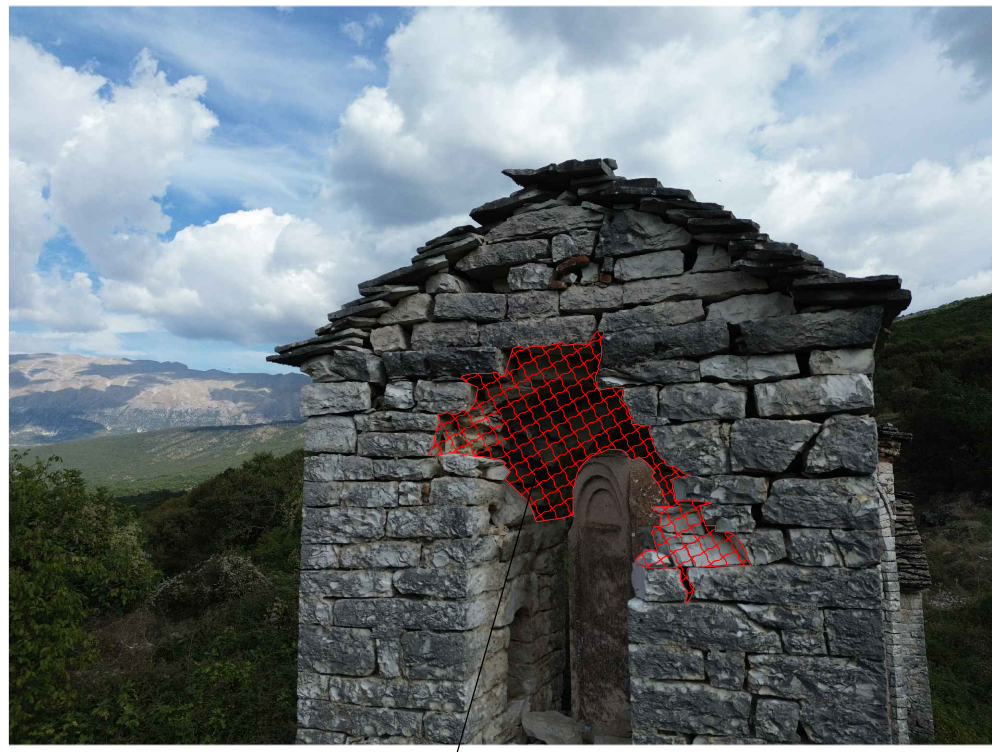
a Pjese e muratures se kambanares ne fasaden lindore e cila shfaq probleme ne qendrueshmeri
