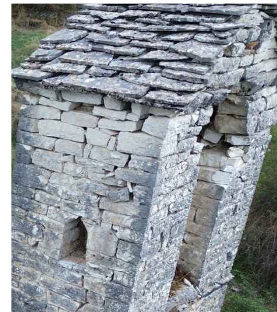
Konsolidim i kreut te murit dhe mbulim pllaka guri
