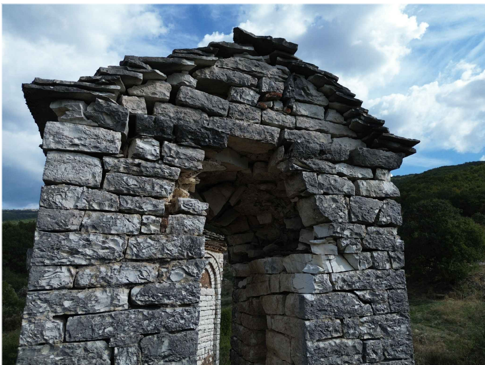
b Mungese e qemerit. Muri i catise ka dale nga vertikaltet. Paraqet suate me rrezikshmeri
