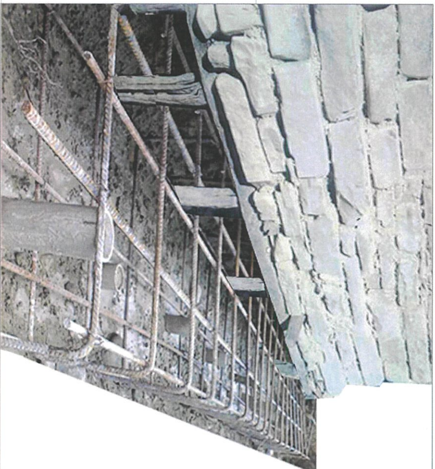
PAMJE E REALIZIMIT TE ARMIMIT TE KEMBES
